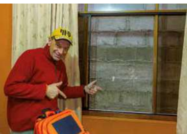
Kollege mit Brett vor dem Kopf? Nein, im Hotel in Santa Teresa ist es gleich eine ganze Mauer aus Leichtbetonsteinen.
