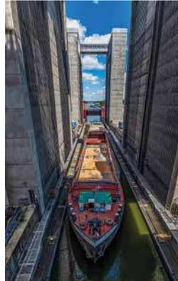
**Eine Etage höher, bitte: Das Schiffehebewerk in Scharnebeck überwindet 38 Meter Höhenunterschied – und zählt zu den größten der Welt**
