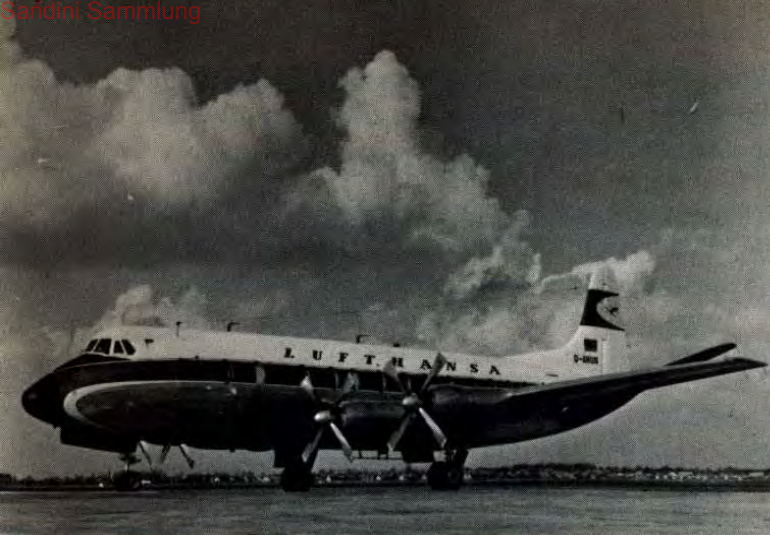
Vickers Viscount 814, ein Turboprop für 64 Passagiere, fliegt 540 km/st.
