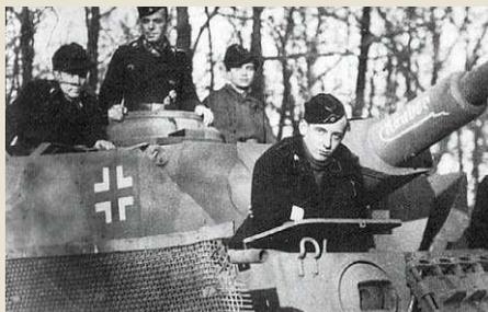
Ein typischer später Panzer IV der Ausführung J mit Thomaschürzen und an diesem Fahrzeug die u-förmigen Hebeösen an der Stirnpanzerung
