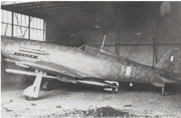
Auch bei der italienischen Luftwaffe sollten Torpedojäger eine Rolle spielen. Um die Fiat G.55 dafür nutzen zu können, musste man den Kühler links und rechts unter der Tragfläche verlegen. Im August 1944 flog nur dieser eine Prototyp G.55/S
