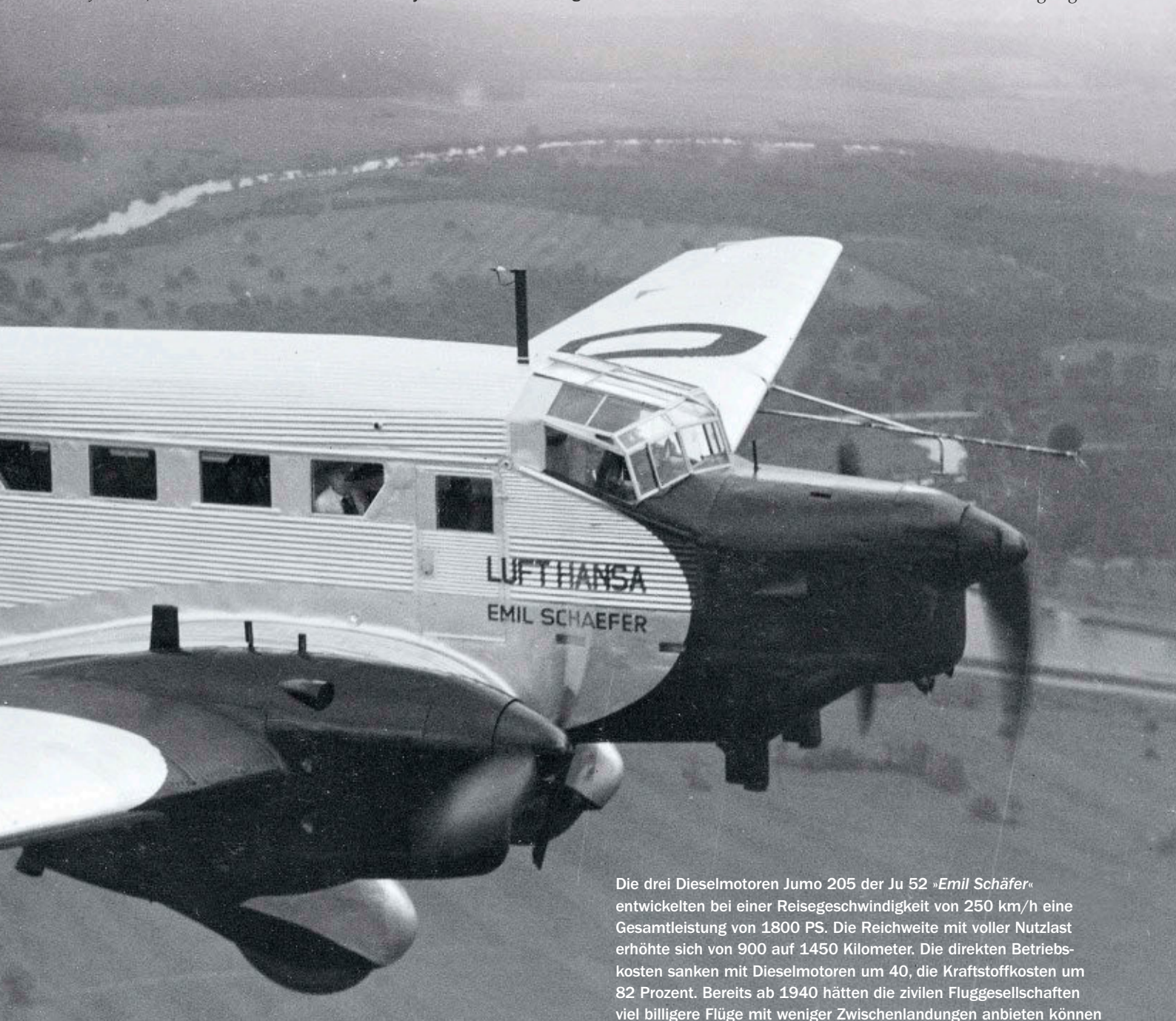
Blick ins Cockpit der Ju 52 mit drei Schwerölmotoren Junkers Jumo 205 zu je 800 PS Startleistung
