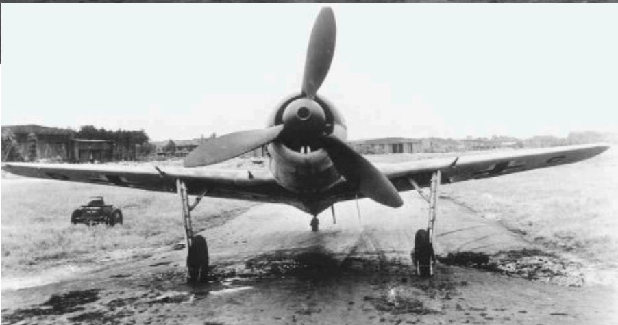
Die V53 war voll ausgerüstet mit vier MG 151/20 im Flügel und zwei MG 131 im Rumpf. Die Luftschaube zeigt die Öffnung für den möglichen Einbau einer Motorwaffe
