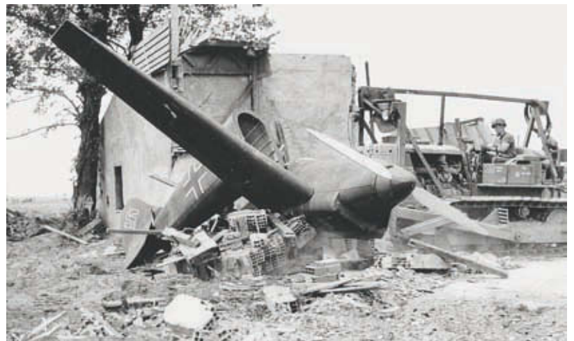
Scheinflugplätze mit Flugzeugattrappen sollten die angreifenden Bomber in die Irre führen. Hier beseitigt ein amerikanischer Bulldozer die Reste der Holzattrappen
