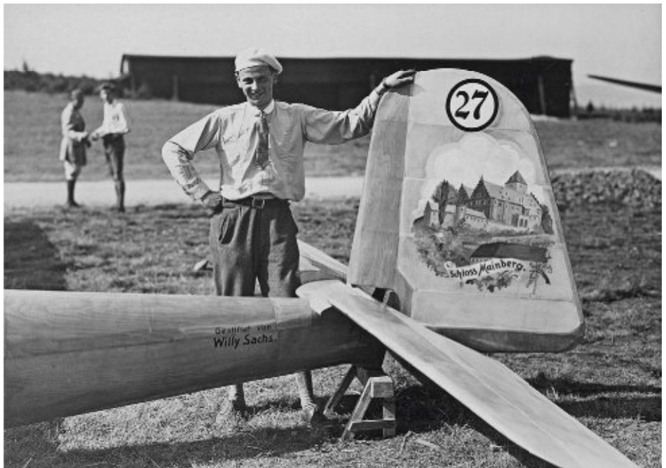
Edgar Dittmar, Schweinfurt, am Leitwerk der »Schloss Mainberg« im Jahr 1929. Die handwerklich saubere Sperrholzarbeit spiegelt sich in der kunstvollen Bemalung des Seitenruders
