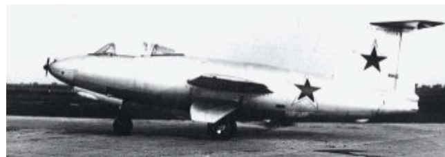
Der I-300-Prototyp war das allererste Jagdflugzeug mit Strahltrieb aus dem Hause MiG. Aleksej Nikolajewitsch Grinshik führte am 24. April 1946 den Erstflug der mit zwei BMW 003 A-1 ausgerüsteten I-300 durch
