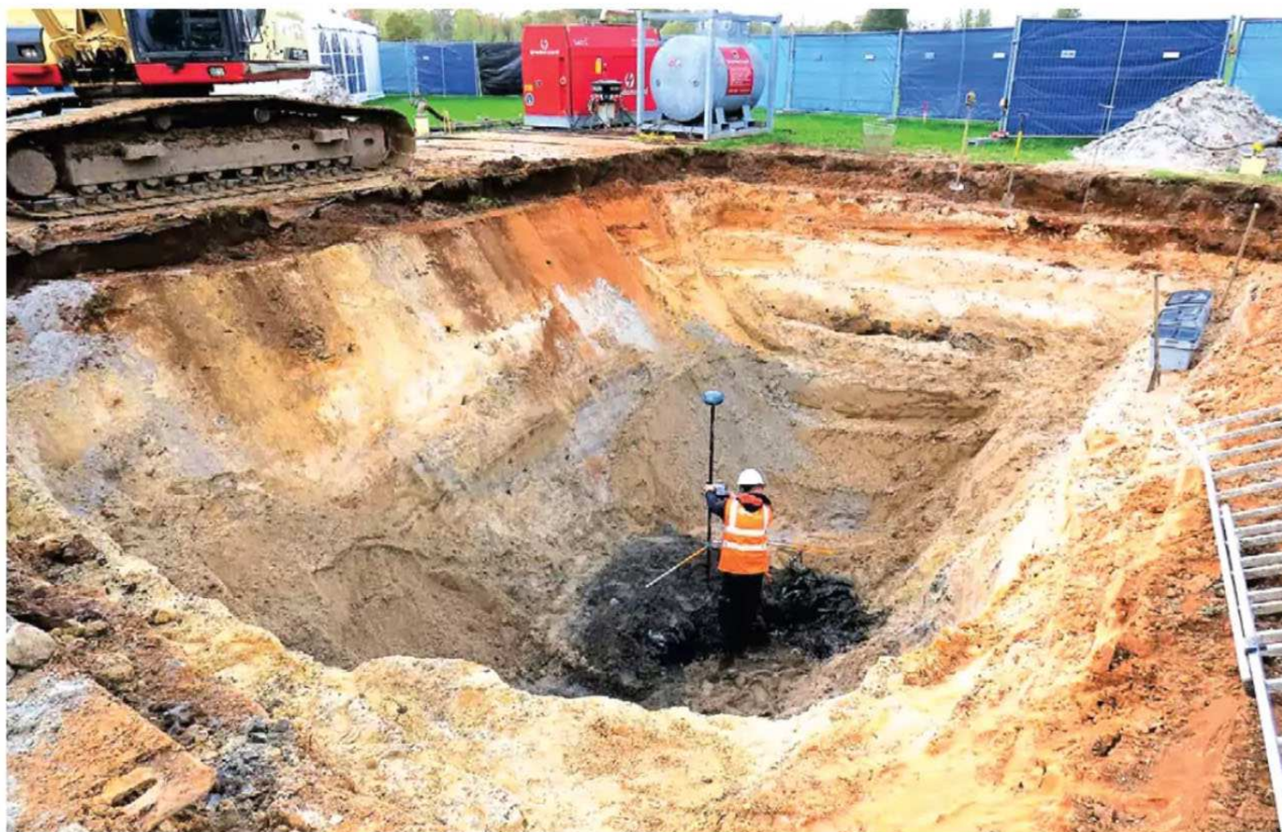
Einmessen der Absturzstelle im metertiefen Baggerloch
