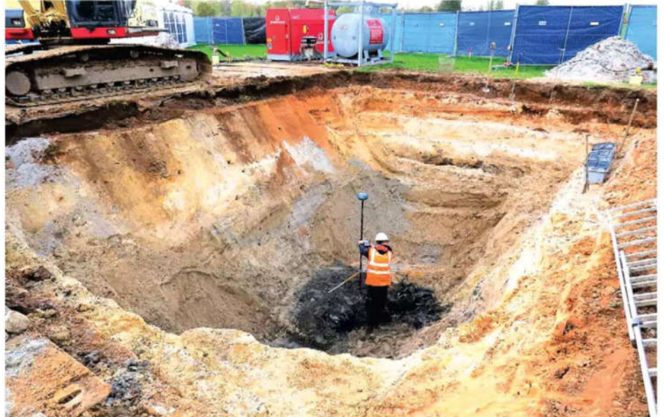
Einmessen der Absturzstelle im metertiefen Baggerloch
