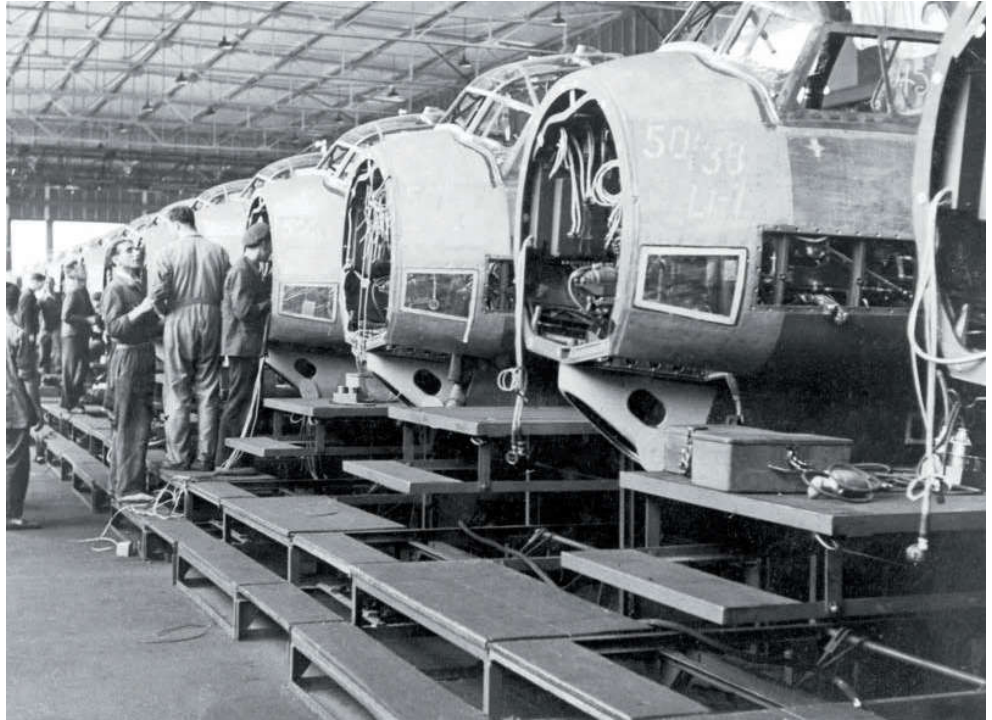
In Aschersleben fand der Großreihenbau der Ju-88-Rümpfe für die Bernburger Endmontage statt
