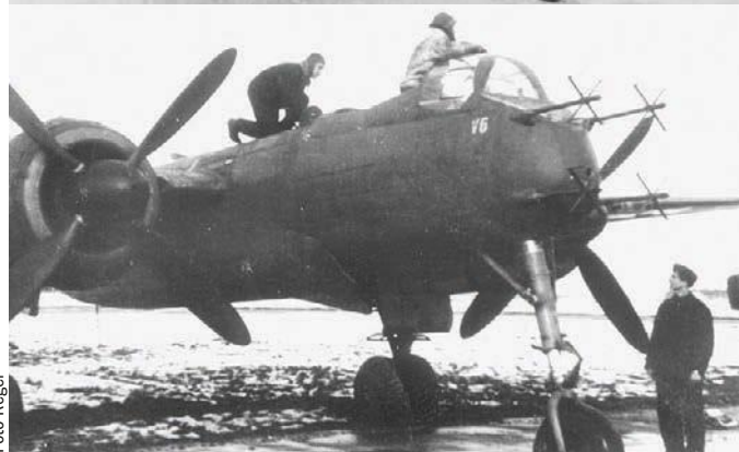
Als Versuchsträger für schwere 3-cm-Kanonen erprobten die Deutschen die He 219 V5 mit der MK 108 und MK 103
