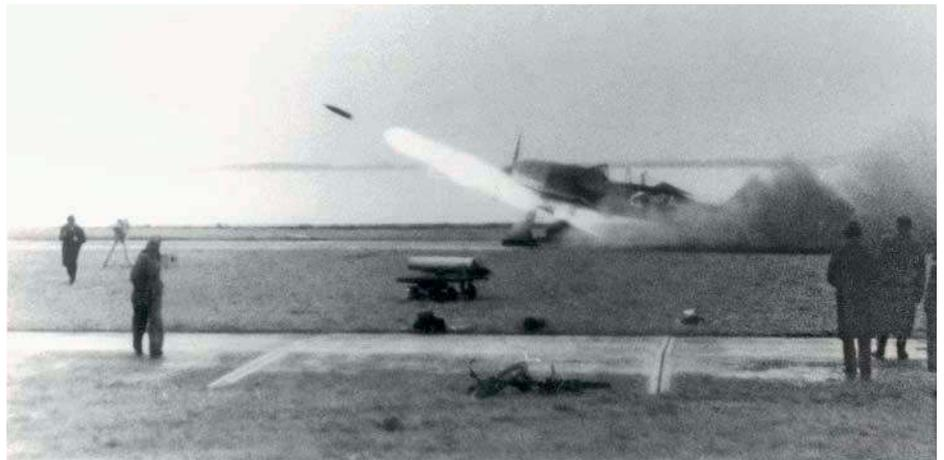
Eine 21-cm-Granate schießt aus dem linken Rohr unter der Fw-190-Tragfläche. Dabei wirbelt die Granate jede Menge Staub auf
