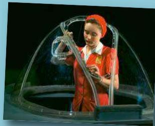
den Bau stromlinienförmiger Cockpithauben oder Bombenschützenfenster, wie zum Beispiel bei der Boeing B-17.
