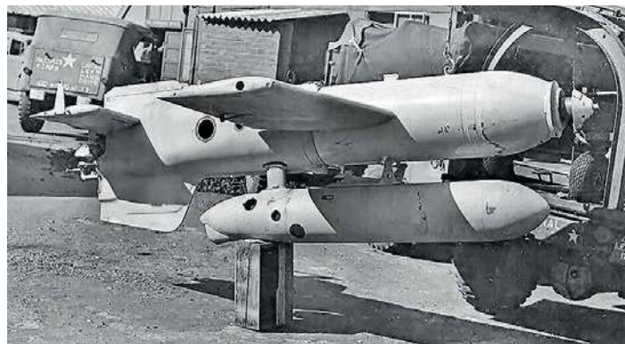
14 Die Gleitbombe Hs 293 galt als »Wunderwaffe« gegen alliierte Schiffe. Do-217-Pilot Kalmbach führte sie in seinen Einsätzen mit
