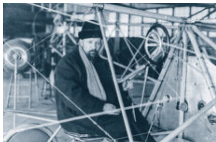
Russe in den USA George de Bothezat entwickelt für das U.S. Army Air Corps. Sein Helikopter mit vier Rotoren schafft 1922 eine Flugzeit von 1:42 Minuten
