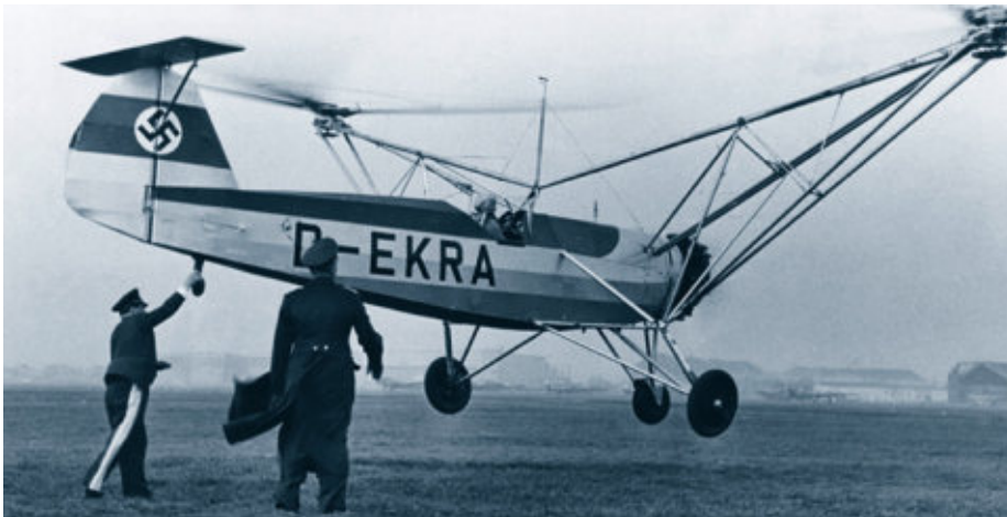
Durchbruch Der Focke-Achgelis Fa 61 überbietet 1937 alle Hubschrauber-Weltrekorde: 2439 Meter Höhe, 80 Kilometer Strecke, 1:20 Stunden Flugzeit und 122 km/h Geschwindigkeit
