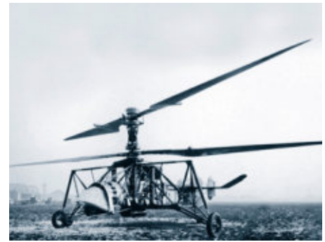
Mit Leitwerk Auch Flugzeugfabrikant Louis Brequet und Ingenieur René Dorand setzen 1935 auf das Koaxial-Prinzip. Es bleibt beim Prototyp
