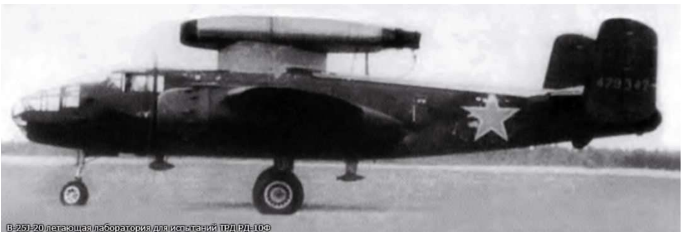
Die B-25 Mitchell als fliegendes Laboratorium für das Nachbrennertriebwerk RD-10F
