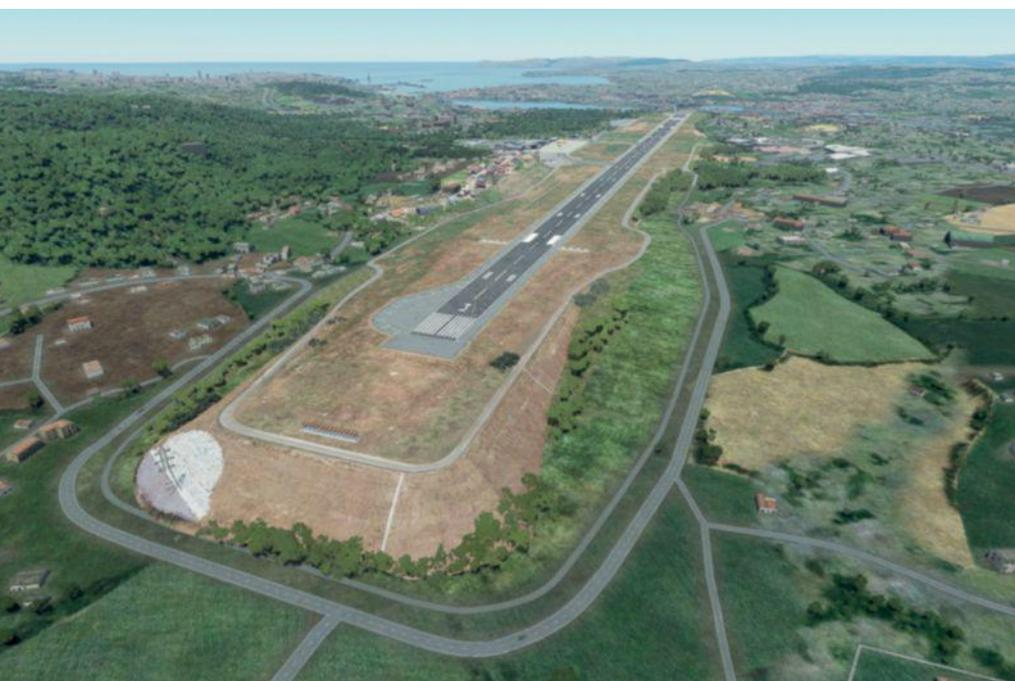
Die einzige Runway 03/21 ist 2.188 Meter lang und 45 Meter breit. Kurz nach dem Wenderondell der 21 stürzt das Gelände rund 15 Meter tief auf die Ebene einer Straße ab. Um die Bodenwarn-Radare anfliegender Flugzeuge nicht zu verwirren, wurden vor der Bahn etliche Reflektoren auf Masten aufgestellt, die denen der Runway 22 von Genf ähneln.
